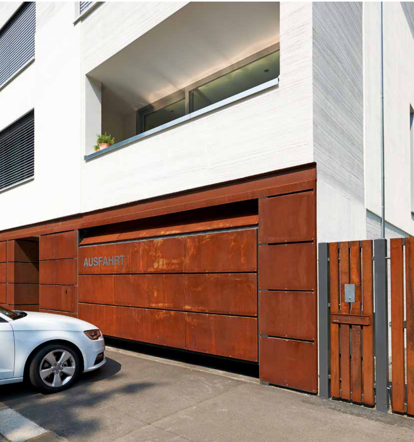
Bauseitige Beplankung mit Schichtpressplatten
