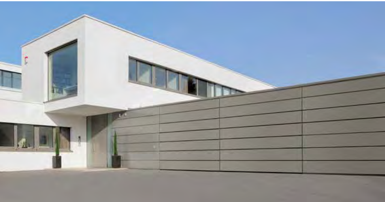
Bauseitige Beplankung mit Aluminium-Verbundplatten
